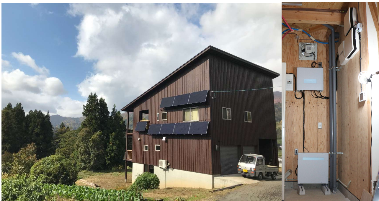
左：東南面、右：デルタ電子・SAVeR-H ハイブリッドシステム（宅内）
