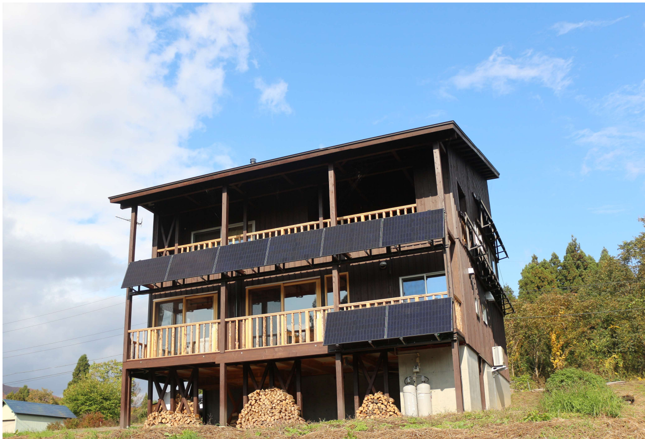
写真：南西からシステム全景（南西面、東南面 2 アレイ）、独立 MPPT 回路により、南西面、東南面アレイの発電をコントロール
